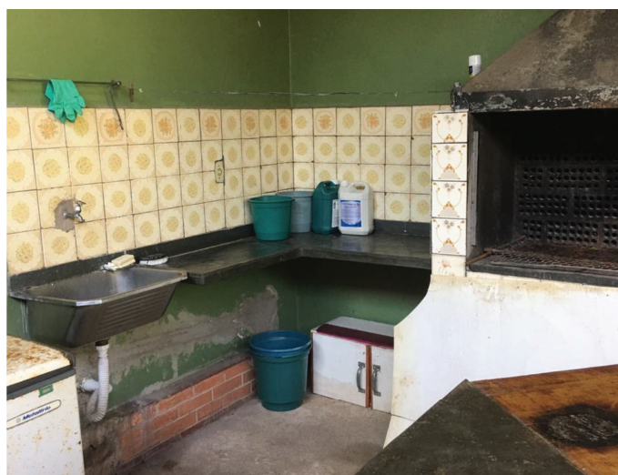
Figura 11: No ponto de assistência da Base Nova Parelheiros, os trabalhadores têm que realizar limpeza de materiais em locais improvisados.
